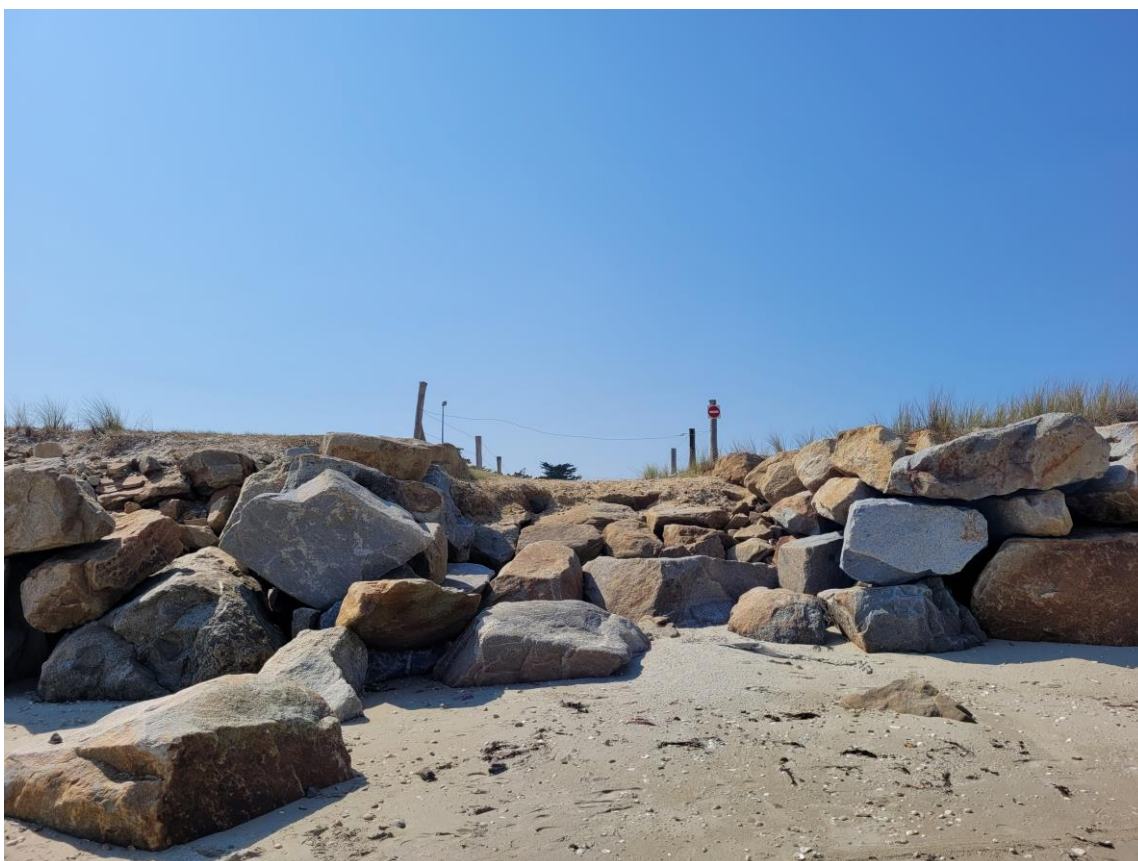
Photo de l'accès condamné : spq-m3-1_jj-aa-mm
