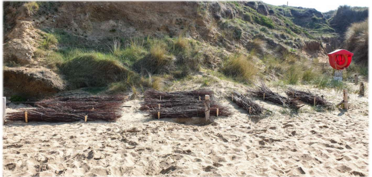
▼ Fagots de Tamaris à Baluden (Belle-Ile)
