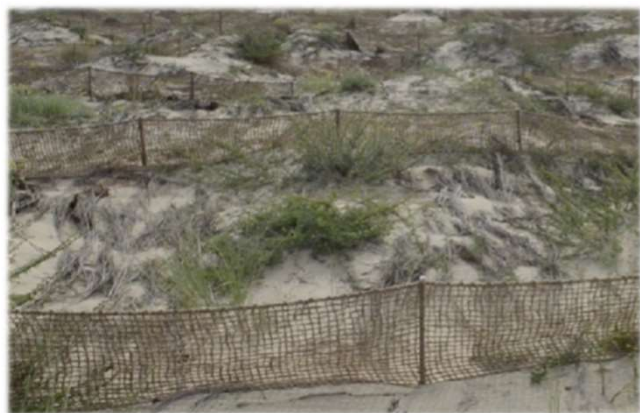
▲ Palissade en filet-coco (LeCap-Ferret)
