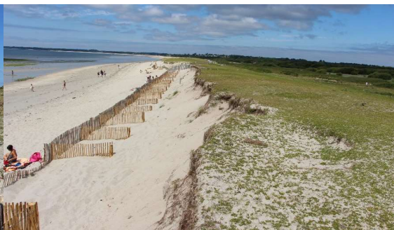
Juillet 2014 (après installation)
