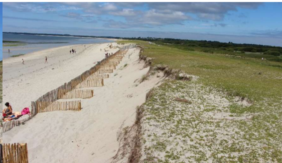
Juillet 2014 (après installation)
