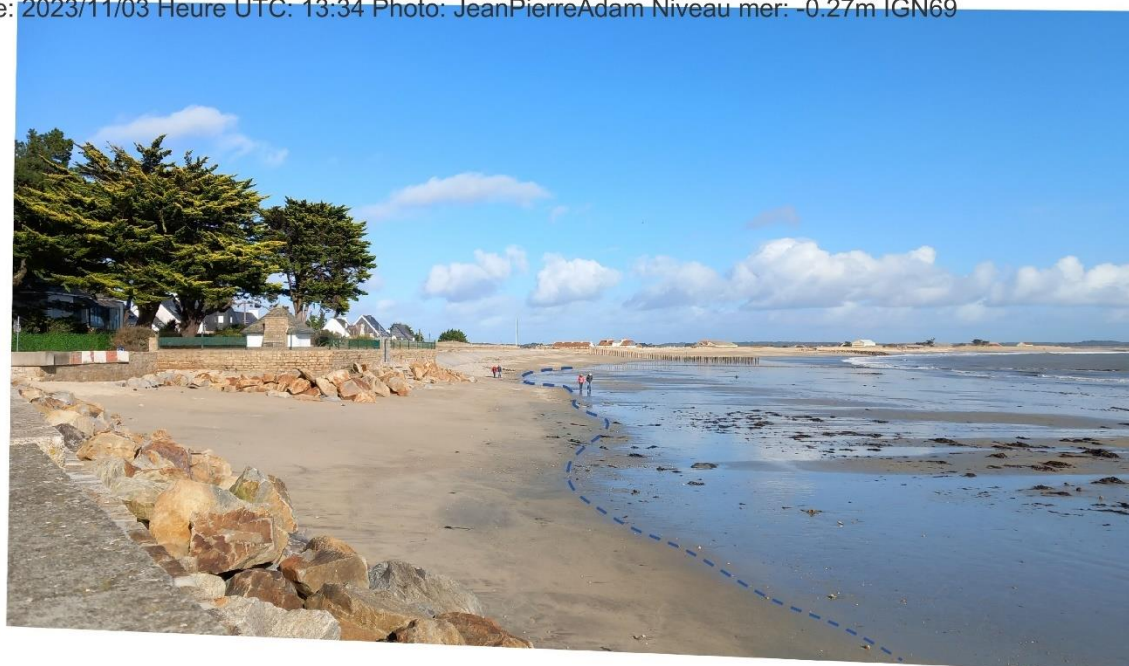
Figure 3 : Création de la rupture de pente post tempêtes
