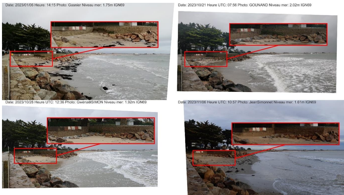
Figure 2 : Gain progressif de sédiment au niveau du batardeau lors de conditions d'agitation
