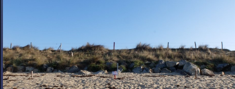
Enrochements + clôture (1990 ou avant)
