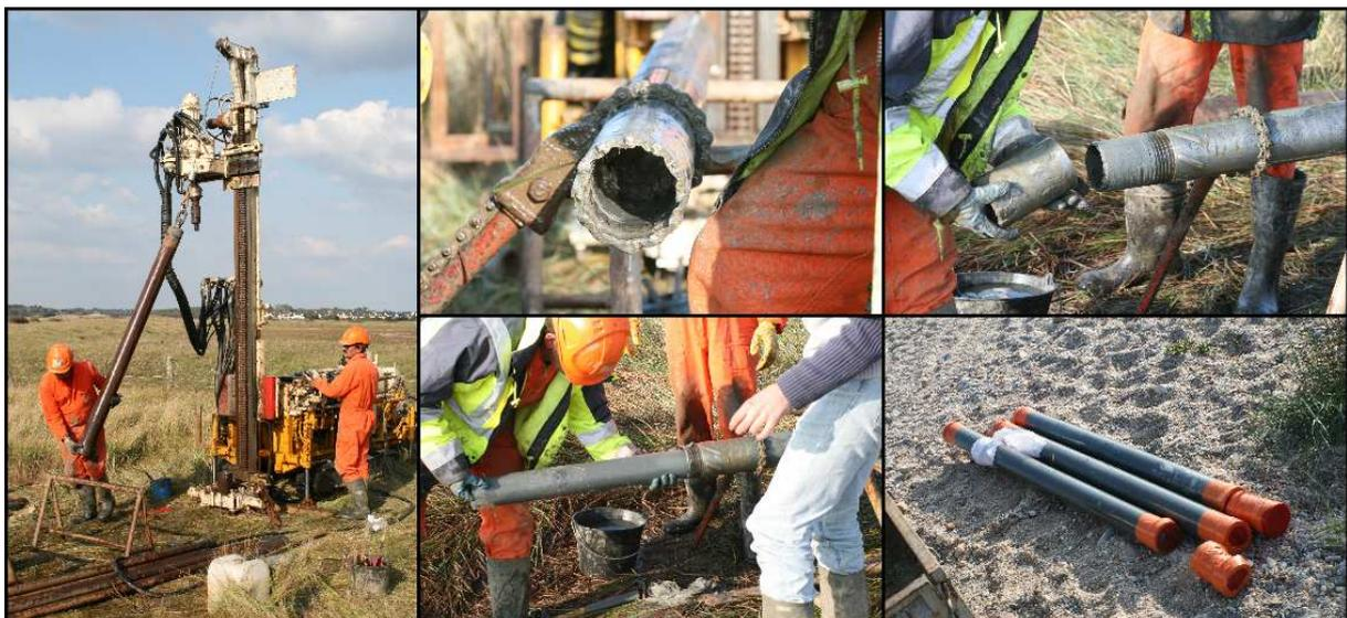
Figure II.6 : Dispositif du rotocarottier mis en œuvre par la société Fugro.
