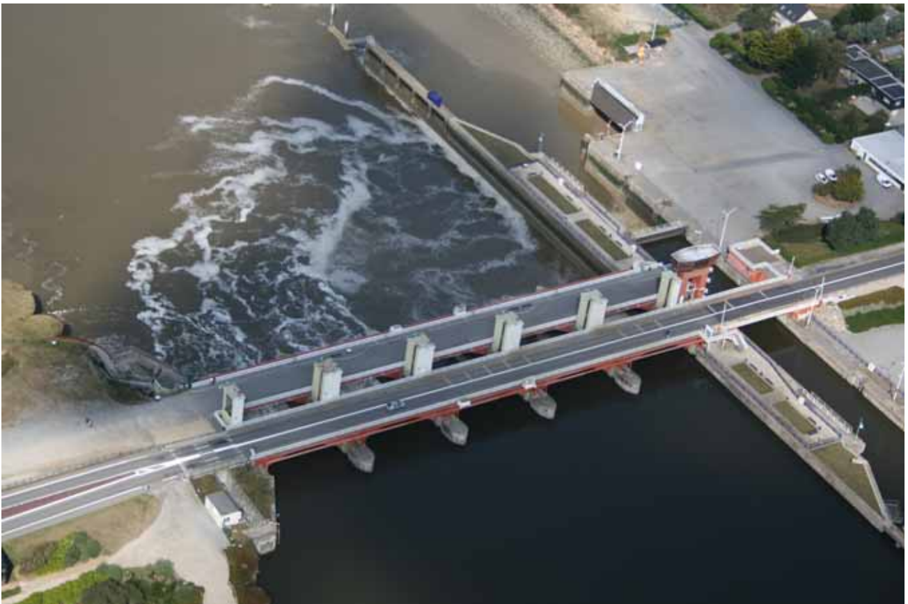
Le barrage d'Arzal
