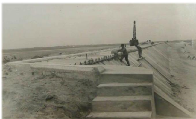
▲ Construction de l'ouvrage de défense côtière le long du tombolo (1952). (Source : Service Historique de la Marine)
