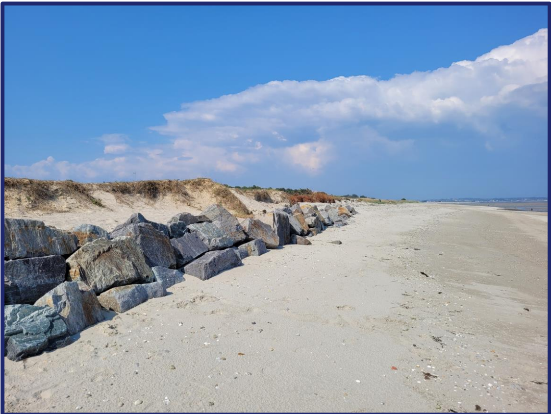
Photo vers le Nord : aaaa_mm_jj-m5-2
